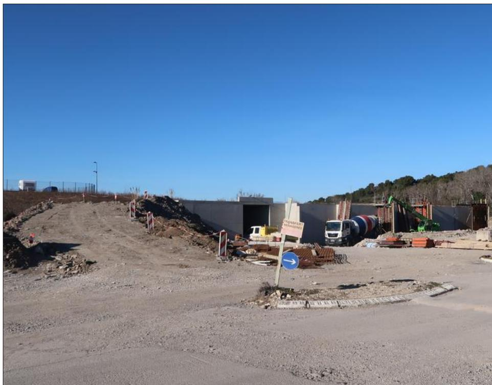
À gauche, la rampe de sortie des camions est déjà visible sur le chantier. Le site continue de fonctionner pendant les travaux et l'ancien bâtiment sera ensuite détruit. Photo TH architecte et Photo Le DL/S.M.
