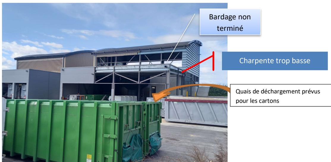
Fig. 5a – Quai de transfert du grenouillet – Bâtiment collecte sélective
